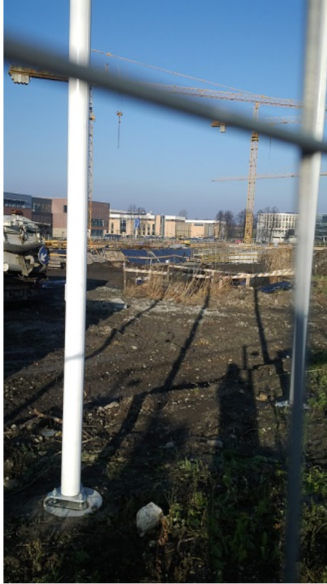
Budowa Wydziału Chemii UJ
