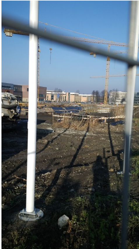
Budowa Wydziału Chemii UJ
